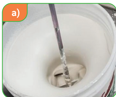
84-nji surat. Şpaklyowka çalmagyň basgançaklary: a) şpaklyowkany mikser bilen taýýarlamak; b) şpaklyowkany çalmak; c) naždak kagyz bilen tekizlemek.
