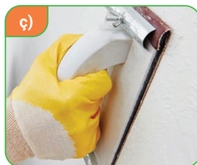
84-nji surat. Şpaklyowka çalmagyň basgançaklary: a) şpaklyowkany mikser bilen taýýarlamak; b) şpaklyowkany çalmak; c) naždak kagyz bilen tekizlemek.
