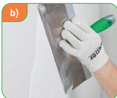
84-nji surat. Şpaklyowka çalmagyň basgançaklary: a) şpaklyowkany mikser bilen taýýarlamak; b) şpaklyowkany çalmak; c) naždak kagyz bilen tekizlemek.
