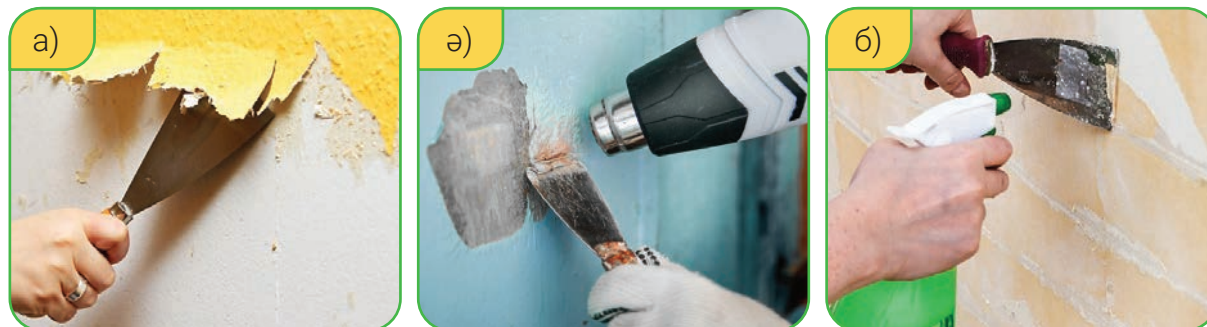
82-сурет. Қаптамаларды тазалау тәсілдері: а) механикалық тәсіл; ә) термикалық тәсіл; б) химиялық тәсіл.
