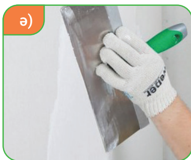
84-сурет. Шпаклёвка жағудың басқыштары: а) шпаклёвканы миксермен дайындап алу; ә) шпаклёвканы жағу; б) құм қағазбен тегістеу.
