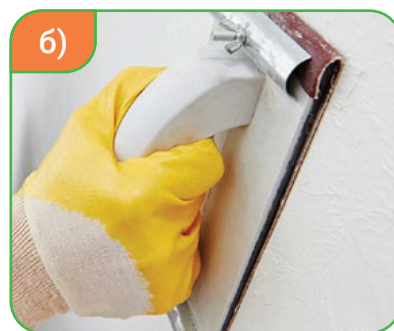
84-сурет. Шпаклёвка жағудың басқыштары: а) шпаклёвканы миксермен дайындап алу; ә) шпаклёвканы жағу; б) құм қағазбен тегістеу.
