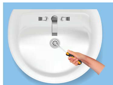
Рисунок 59. Снятие сифона.
