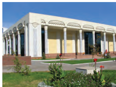
Бейнелеу өнері галереясы
