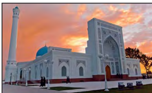
41-rasm. Toshkent. Minor masjidi.
