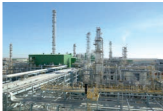
Рис. 29. Завод по переработке нефти.
