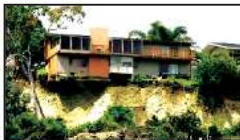
Рис. 26. Разрушения вследствие стихийного бедствия.
