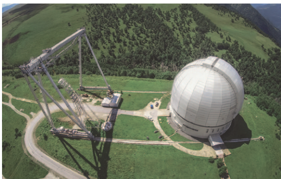
Рис. 37. Башня установленного на Северном Кавказе телескопа-рефлектора с диаметром зеркала 6 м.
