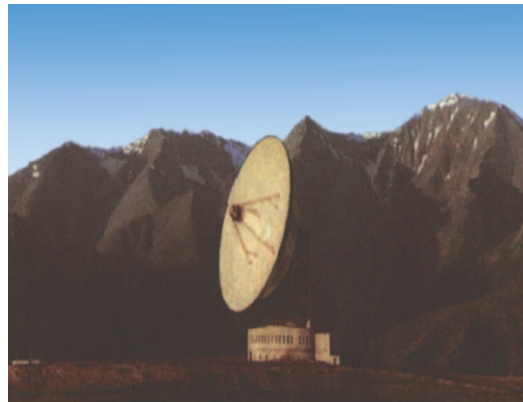
41-nji surat. Jyzzak welaýatynyň Zomin daglarynyň eteginde gurulýan, metal aýnalý diametri 70 metrlik radioteleskop.
