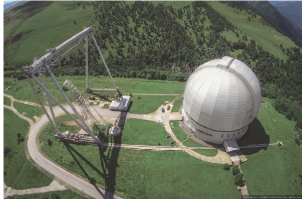
37-nji surat. Demirgazyk Kawkazdaky aýnanyň diametri 6 metrlik teleskop-reflektor minarasynyň görnüşi.
