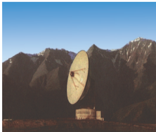
41-rasm. Jizzax viloyati Zomin tog‘lari etagida qurilayotgan, metall ko‘z gusining diametri 70 metrli radioteleskop.
