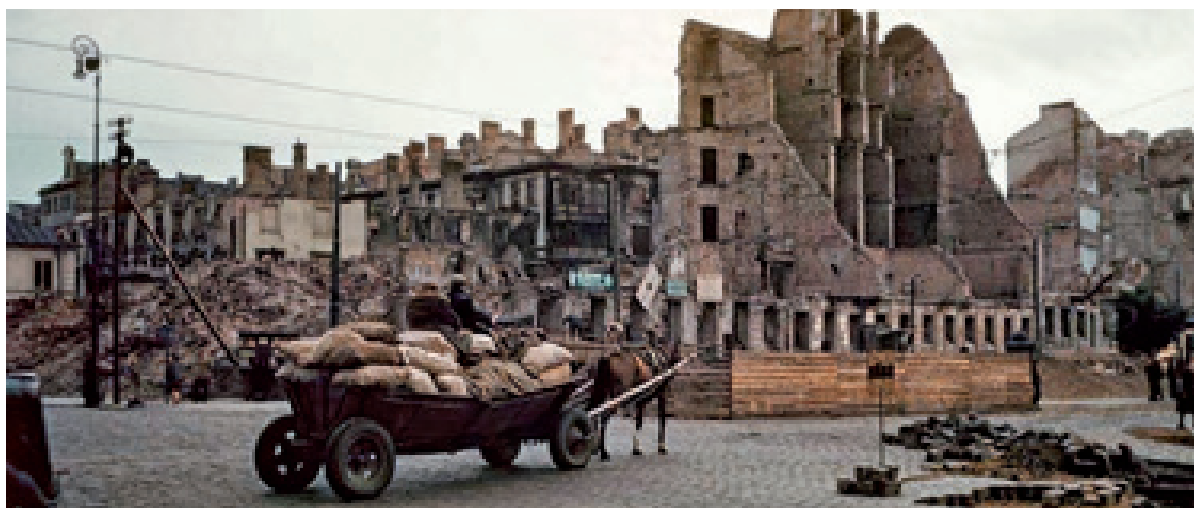
Ремонт дорог в Варшаве в послевоенные годы
