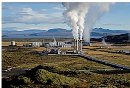
4-nji surat. Islandiýadaky geotermal elektrostansiýalardan biri.
