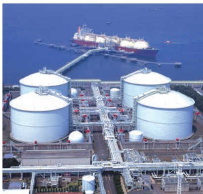
Рис. 16. Резервуары для хранения сжиженного природного газа
