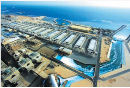
Рис. 70. Завод по опреснению морской воды
