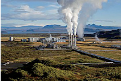
4-súwret. Islandiyadağı geotermal elektr stanciyalarından biri.
