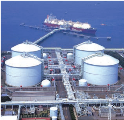
16-сурет. Сұйылтылған табиғи газды сақтайтын резервуарлар.
