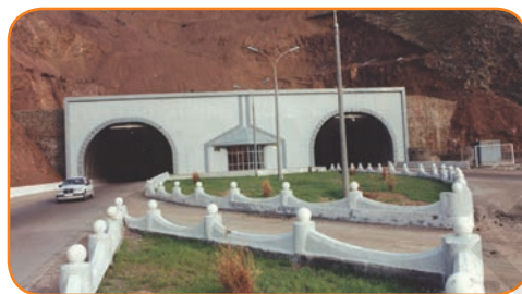
74-nji surat. Kamçyk geçelgesindäki tonnel.
